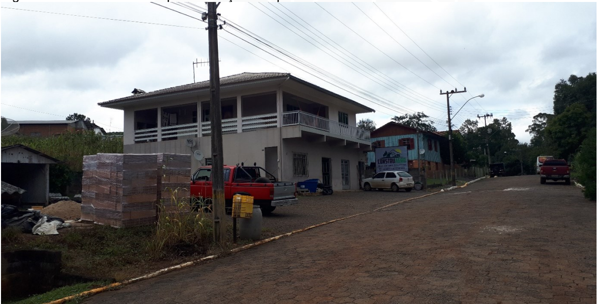
Figura 178 - Inexistência de pavimentação nos passeios na Rua 10 de Maio.
