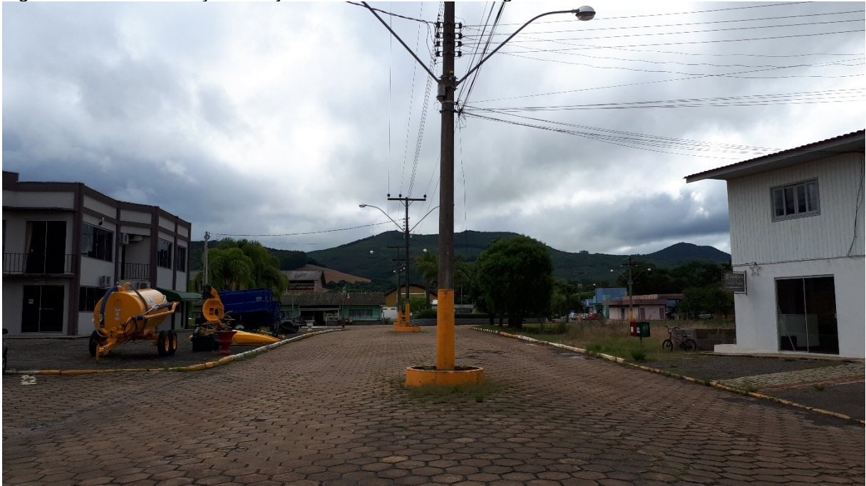
Figura 173 - Pavimentação de lajotas na Travessa Lido Tragancin.
