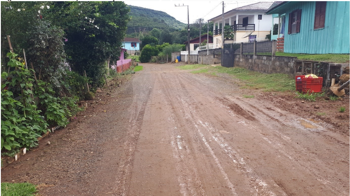
Figura 174 – Falta de pavimentação na Rua João Pedro Dani.
